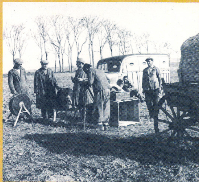
Mesures électriques en Turquie.
